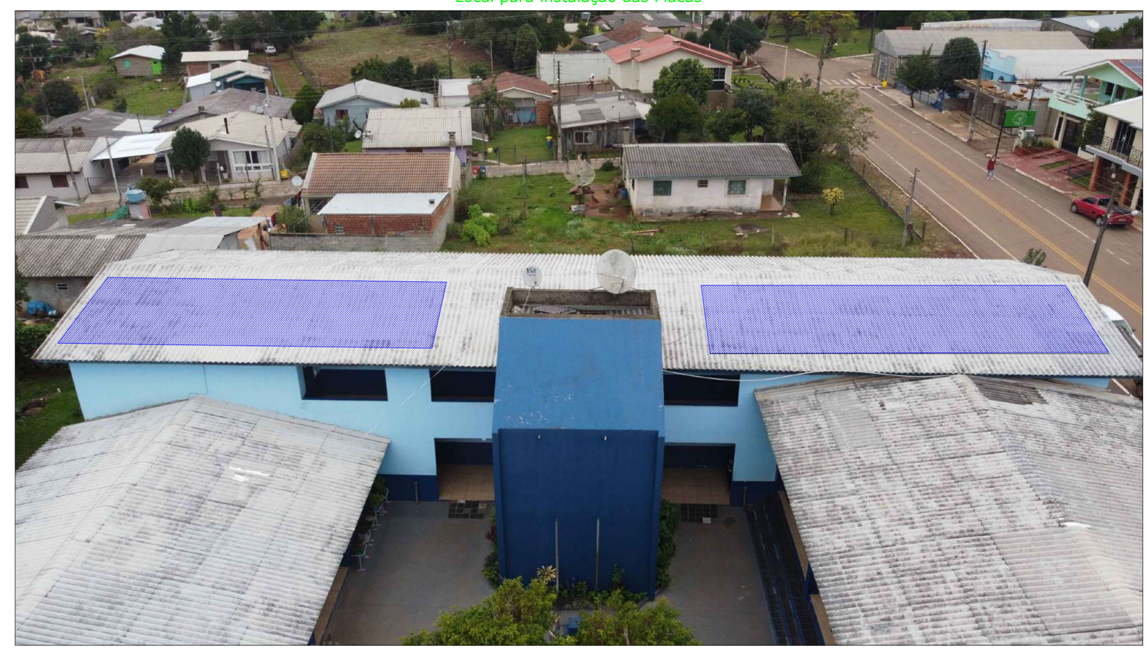
Local para instalação das Placas
